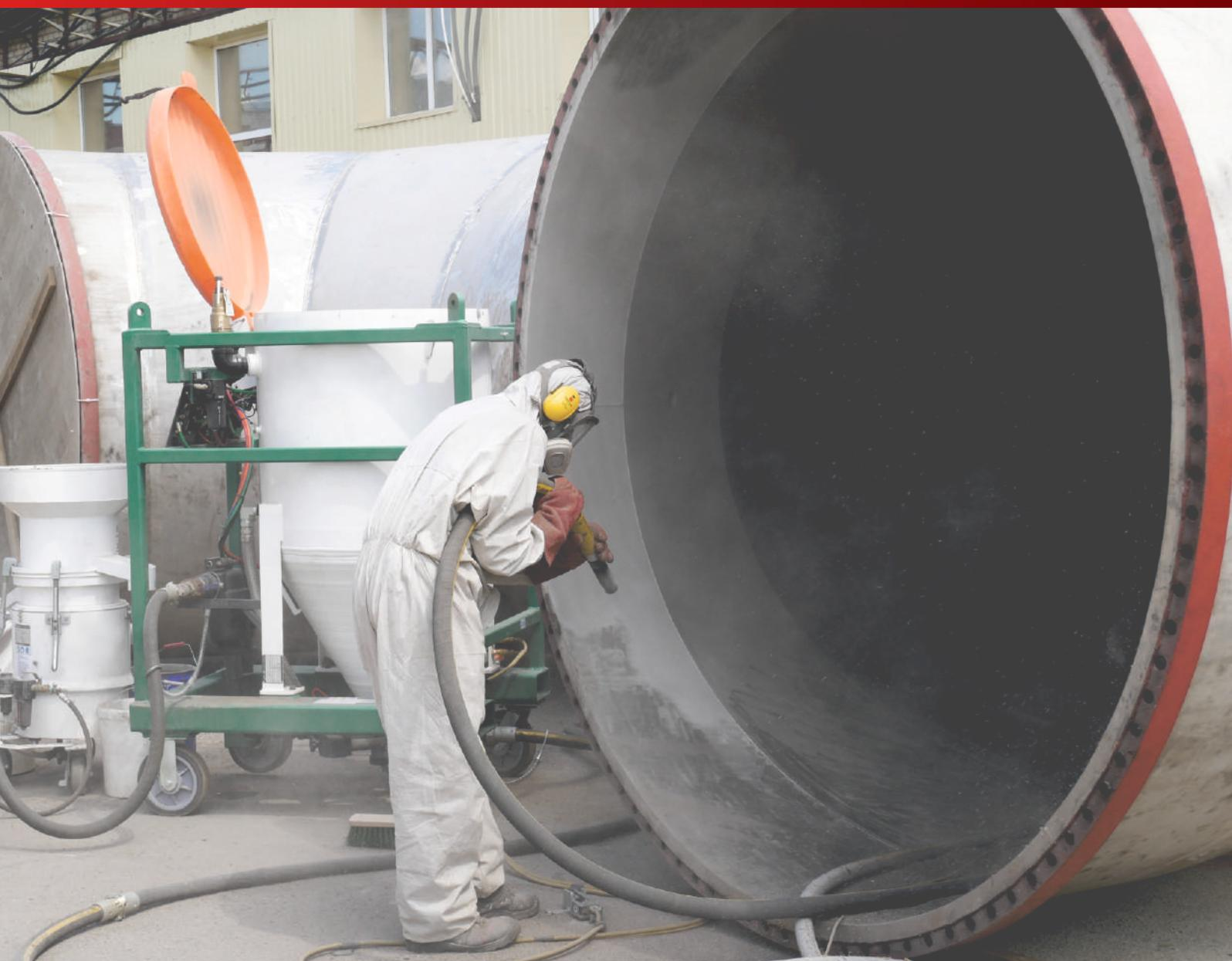
**Технология беспылевой абразивно-струйной обработки**
