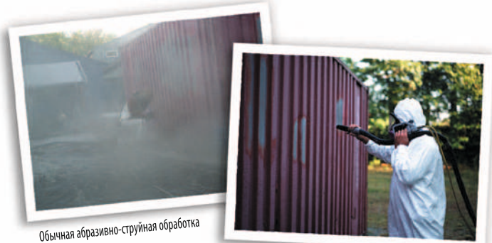
Беспылевая абразивно-струйная обработка с использованием оборудования Sponge-Jet
